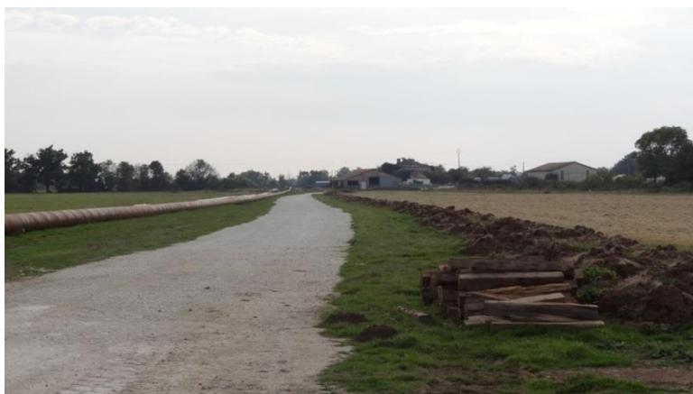
*Tubes assemblés pour le passage sous-œuvre\* sous la Garonne pour la ligne à 225 000 volts Bruges\_Marquis
